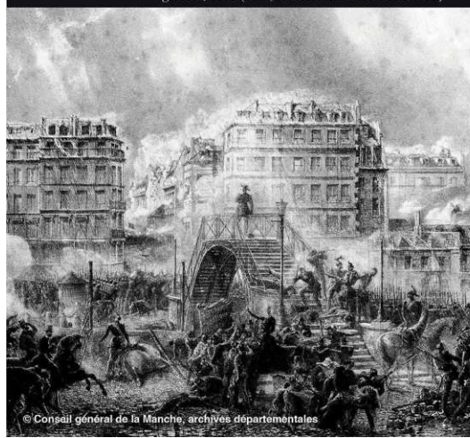
François BONHOMME, 23 juin 1848, prise de la barricade de la place du Petit-Pont , gravure, 1848 (Paris, musée Carnavalet – cl. PMVP)
